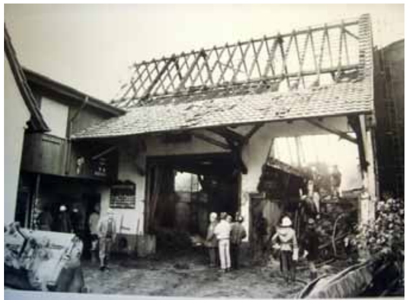
Nach dem Großbrand bei Karl Epple Einsatz in der Nacht des 14.09.84
