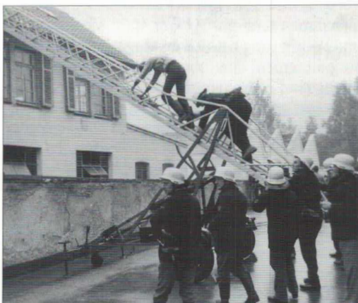
Hauptübung am abbruchreifen Karcher-Gelände im Herbst 1981
